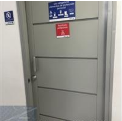
foto 4. Cuarto de almacenamiento,
