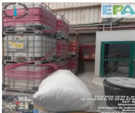
Figura 16. Tanques IBC para almacenamiento de ARnD
