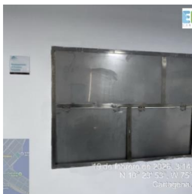
foto 3. Cuarto de almacenamiento
