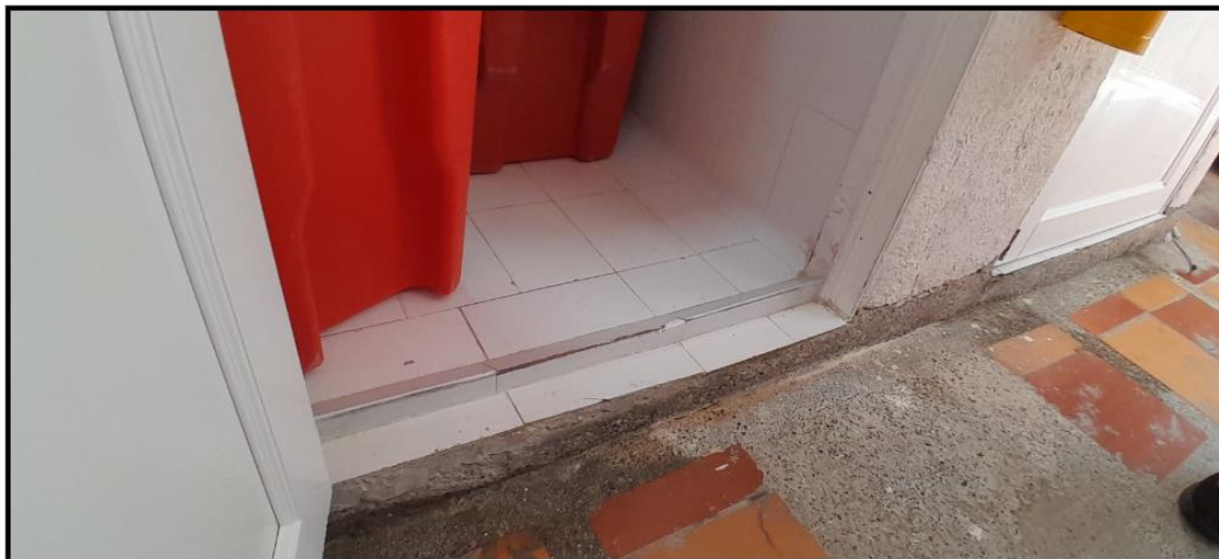
Foto 9 (muro de contención de derrames).
