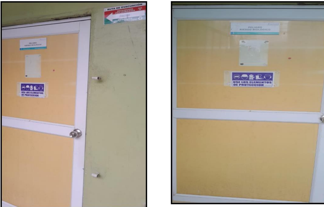
Foto 5. Almacenamiento de RESPEL (Puertas y/o accesos rotulados)
