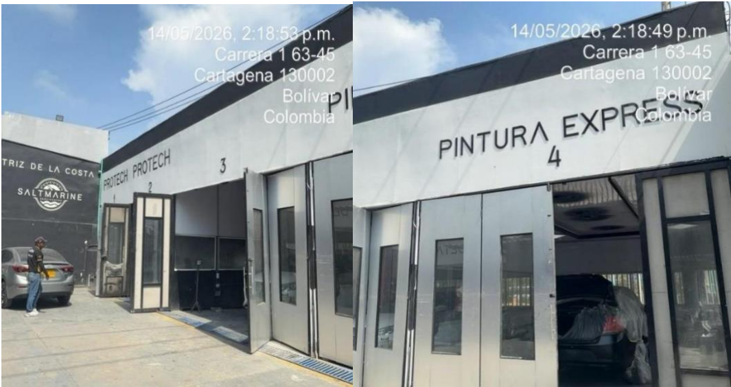
Imagen 3: Cabinas de aplicación anticorrosivo
