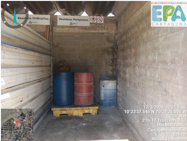
Figura 16. Centro de acopio RESPEL
