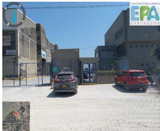
Figura 2. Fachada principal de EDUARDOÑO S.A.S.
