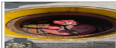
Figura 3. Tanque subterráneo Disel.
