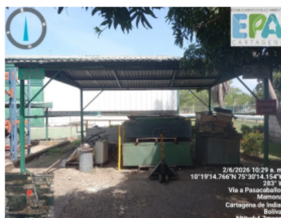
Figura 3. Centro de acopio
