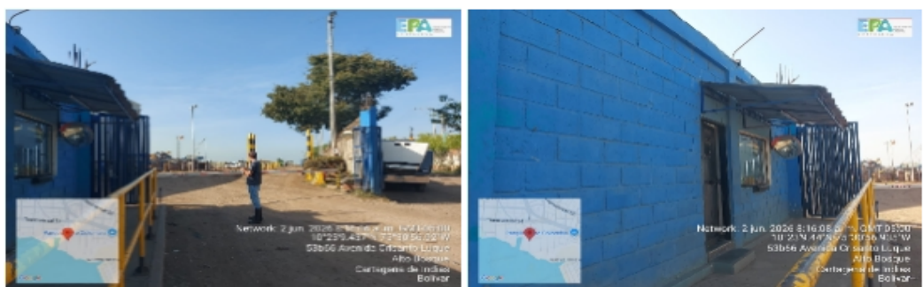
Figura 2 y 3. Fachada Principal de la Empresa DIACO S.A.
