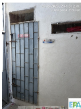
foto 4. cuarto de almacenamiento
