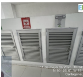
foto 2. Cuarto de almacenamiento
