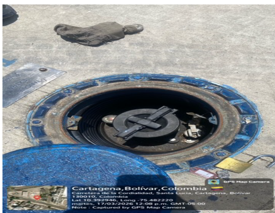
Figura 5. Bocatoma de llenado Extra
