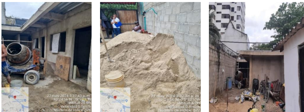
Figura 2. Evidencia de construcción de habitaciones, baño, materiales, herramientas y equipos para el desarrollo de actividades constructivas. Fuente: Autores, 2024.
