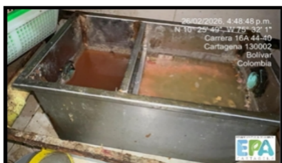
Ilustración 3. Sistema de Tratamiento de Aguas Residuales (Trampa de Grasas)
