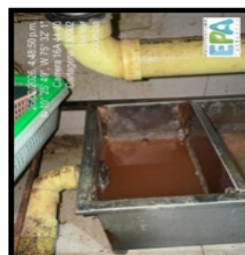
Ilustración 3. Sistema de Tratamiento de Aguas Residuales (Trampa de Grasas)
