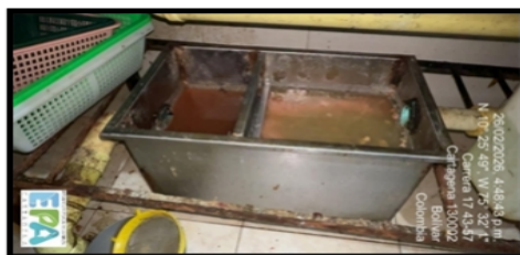
Ilustración 2. Sistema de Tratamiento de Aguas Residuales (Trampa de Grasas)
