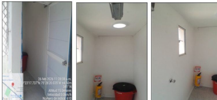
Foto 6 (paredes adecuadas), 7 (iluminación adecuada) y 8 (sin muro de contención).
