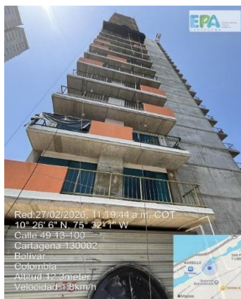
Figura 2. Actividades constructivas del proyecto. Fuente: Autores, 2026
