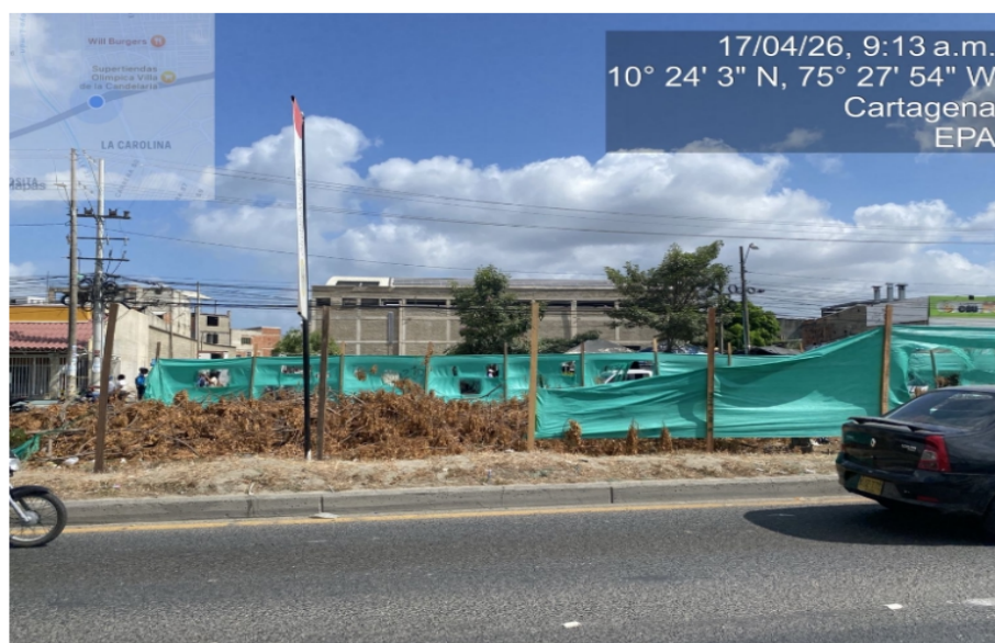
Figura 2. Frentes de obra activos del proyecto de INTERCAMBIADOR VIAL LA
