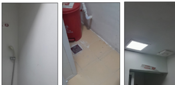
Foto 7 (paredes adecuadas) 8 sin (muro de contención en el área de ecopic) y 9 (iluminación adecuada)
