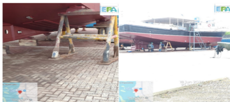
Imagen: Labores De Pintura Al Aire Libre.
