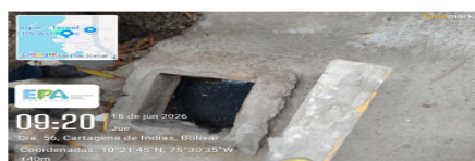
Ilustración 2 Registro Antiguo Poza Septica
