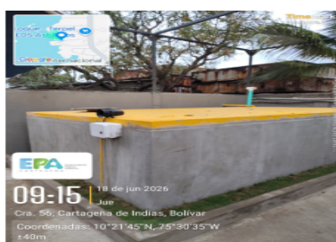
Ilustración 1 Nuevo Tanque de almacenamiento
