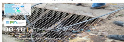
Ilustración 3 Punto de descarga de mangueras conectadas al buque
