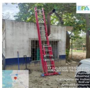
Imagen: Equipo Generador De Energía
