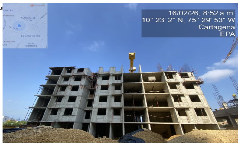
Figure 2. Avance de obra - Proyecto PUNTALTA ALTARENA. Fuente: AUTORES, 2026.
