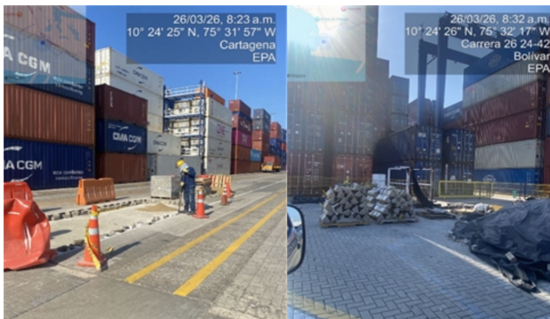
Figura 2. Frentes de obra activos de Sociedad Portuaria Regional de Cartagena. Fuente: AUTORES, 2026.
