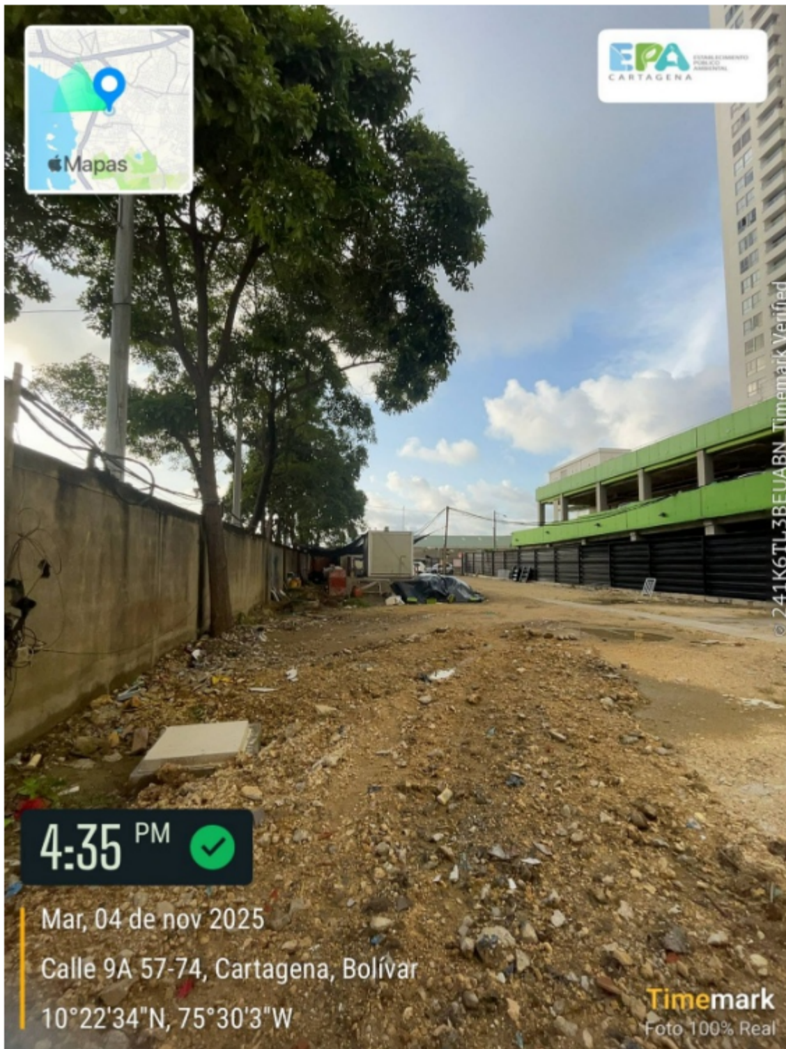
Figure 2. sitio de acopio de material RCD. Fuente: Epa, 2025.
