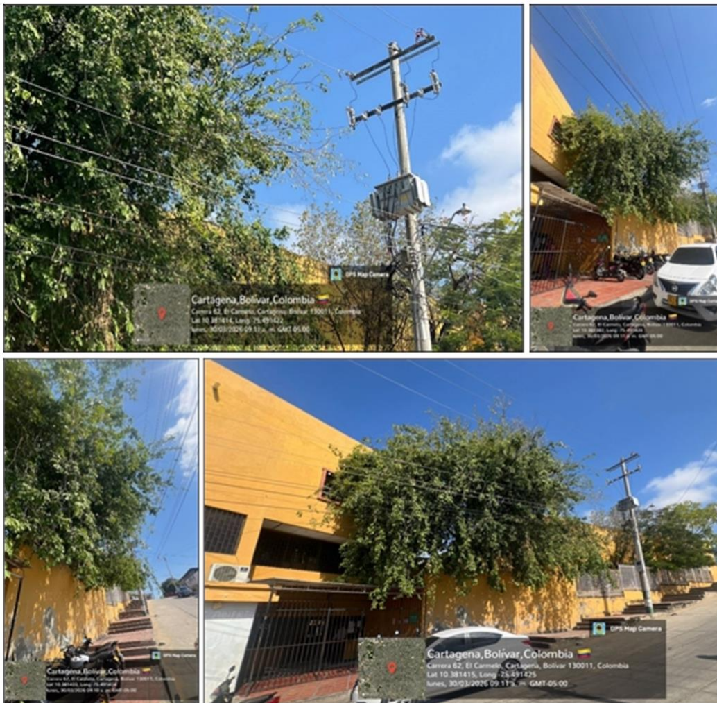
Árbol de granadillo con Ramificaciones entrelazadas con cableado eléctrico de alta tensión
