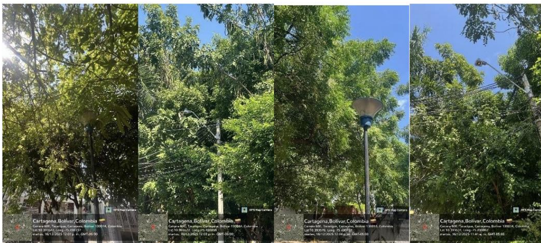
Obstrucción de Luminarias por parte del follaje de arboles
