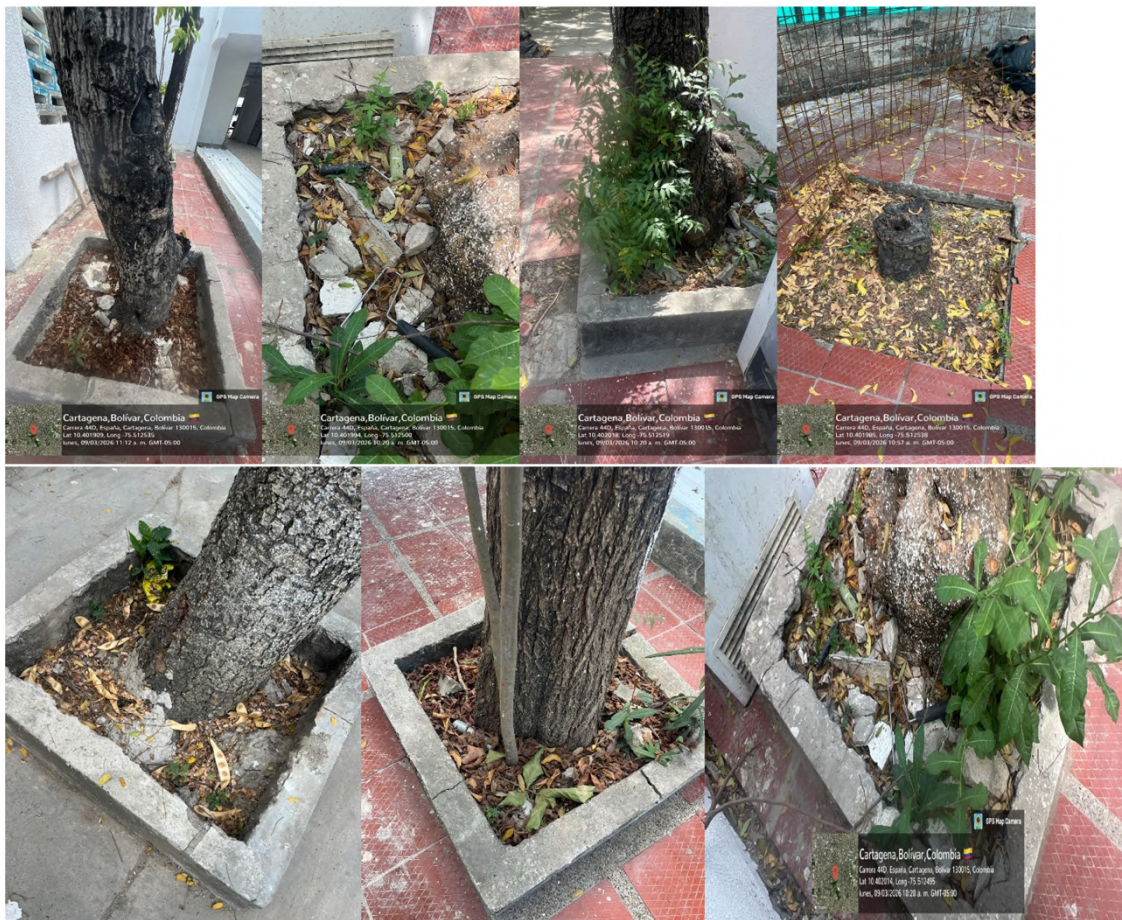
Alcorques de ejemplares arbóreos, rellenos de material de construcción y de dimensiones pequeñas
