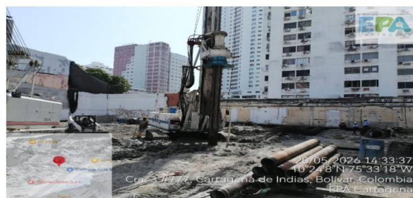
Figura 3. Perforación de suelo
