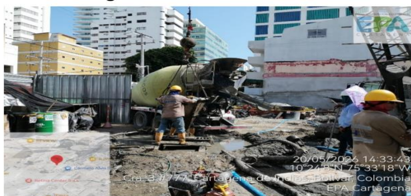
Figura 4. Fundición de pilotaje
